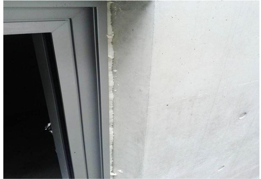
창호 설치 후 단열폼 시공한 외부 모습
