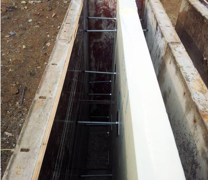
중간단열재 설치 모습
