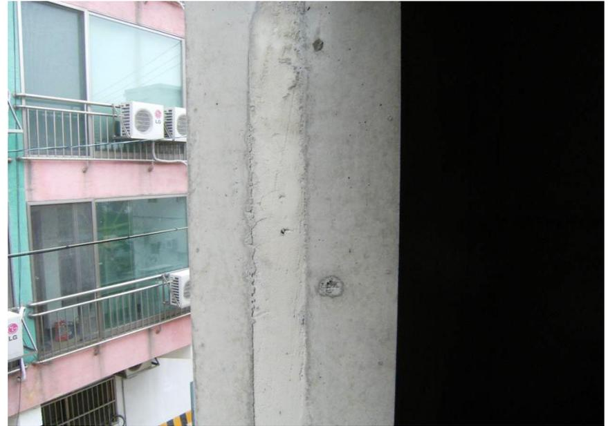
콘크리트 타설 완료 후 거푸집 제거 상태
